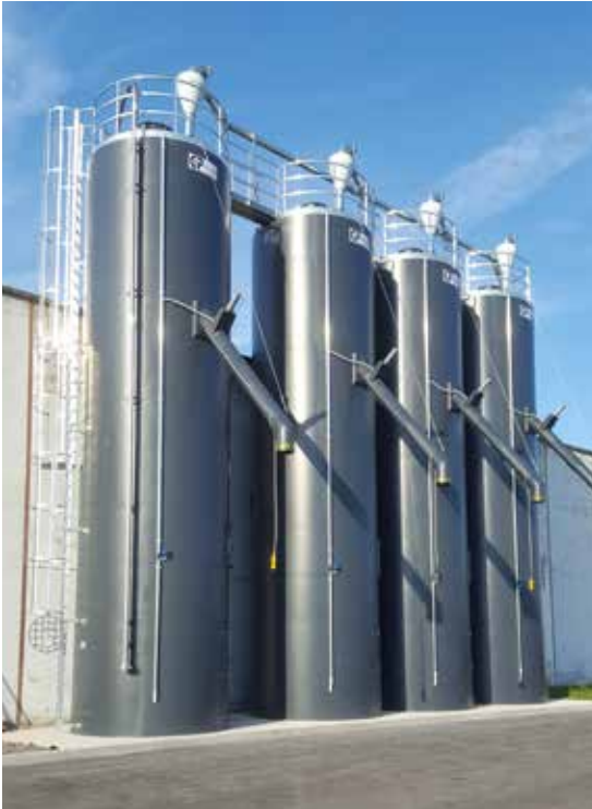
Silos en acier peint ou acier inox jusqu'à 100 m 3 Installation en extérieur, montage sur jupe et vidange camion-citerne
